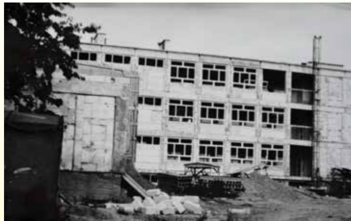
Szkola w budowie
