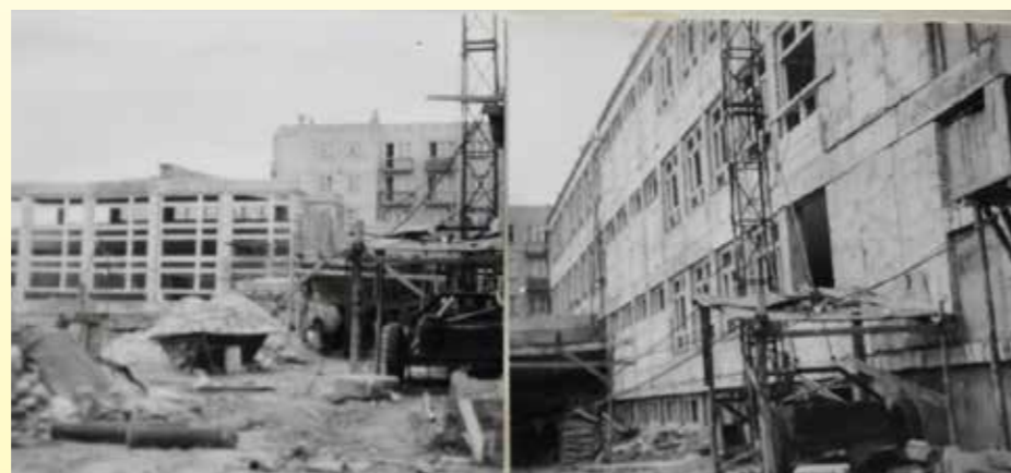
Szkola w budowie
